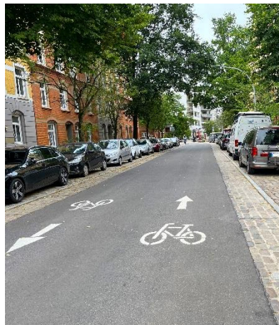
Fahrbahn nach dem Umbau mit Sicherheitsstreifen aus Natursteinpflaster
