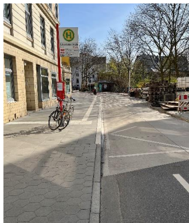
Bushaltestelle „Bahnenfelder Straße“ nach dem Umbau
