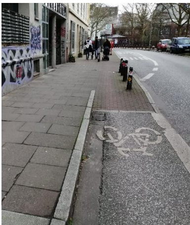
Unzureichende Radwegbreite im Bushaltestellenbereich vor dem Umbau
